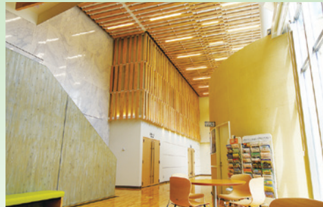
大きな吹き抜けが特徴のガレリアギャラリー (天井・壁に嬢恋産カラマツ材使用)
